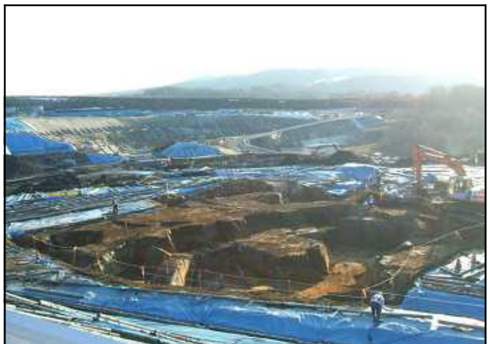
地山の状況（現場北側エリア）
