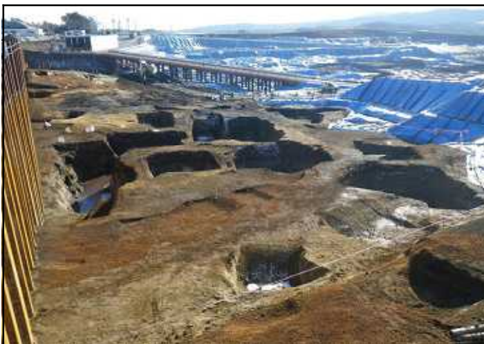
地山の状況（県境部）
