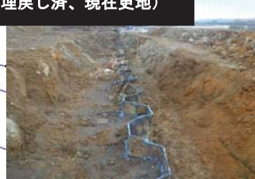
県境鋼矢板 （地中に埋戻し済、現在更地）
