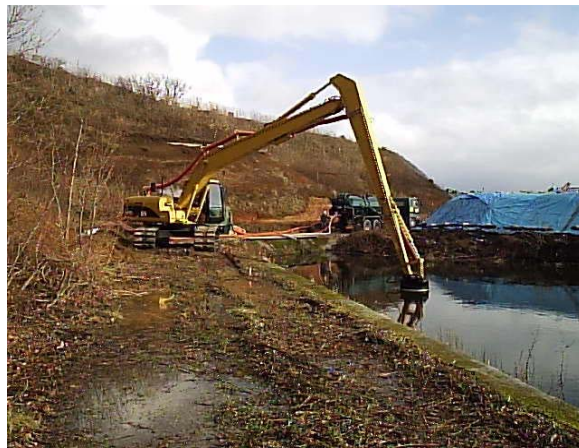
液状廃棄物のくみ上げ
