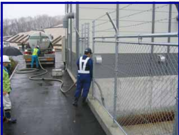
【貯留槽へ地下水を投入する様子】
