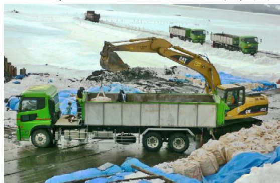
【1日に3台の天蓋車で搬出しました】
