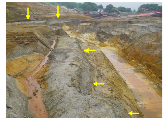
⑪Pf2層（火山灰・火山礫）分布状況 掘削面にほぼ水平に分布 谷部は凝灰岩（風化により粘土質）が分布
