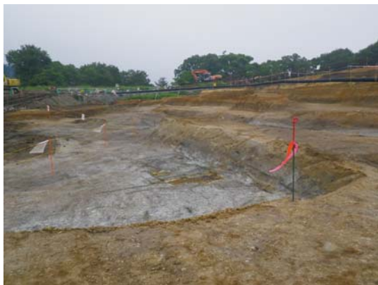
⑦砂質火山灰・火山礫層分布状況 矢印部：Pf2層（火山灰・火山礫）
