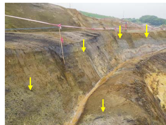
⑫Pf2層（火山灰・火山礫）分布状況 掘削面にほぼ水平に分布
