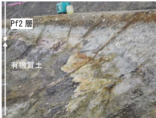
⑤第一帯水層の下面状況 有機質土が分布
