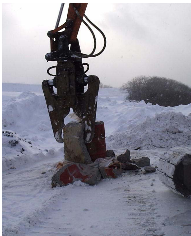
現場におけるコンクリート塊破碎処理作業
