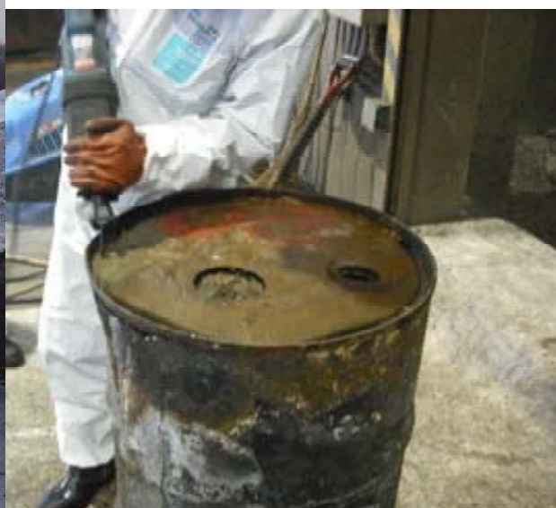
施設におけるドラム缶解体作業
