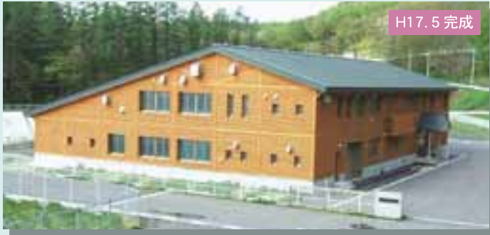
浸出水処理施設
