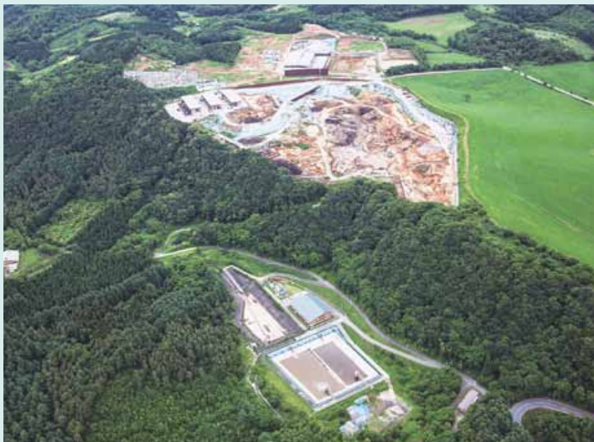
平成25年7月の不法投棄現場全景
