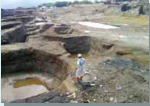
廃棄物の撤去を進めていくうちに、元々の地面の一部に穴を掘り廃棄物が捨てられていることがわかりました。
