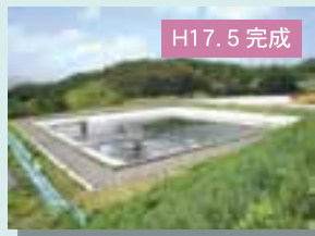
浸出水貯留池
