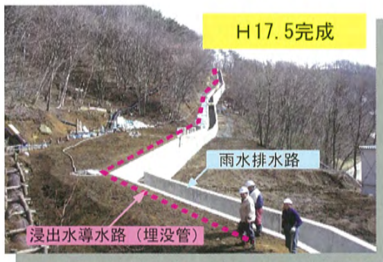
浸出水導水路、雨水排水路
