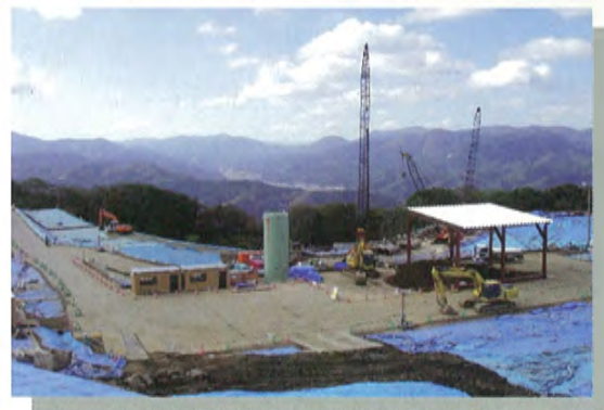
平成17年10月の遮水壁工事状況
