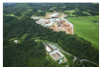
ごみを片づけていた頃の現場 (平成25年7月)
