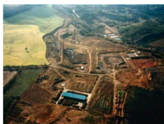
ごみを片づける前の現場 (平成12年10月)
