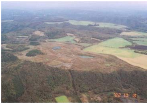
■廃棄物を片づける前の現場の様子
