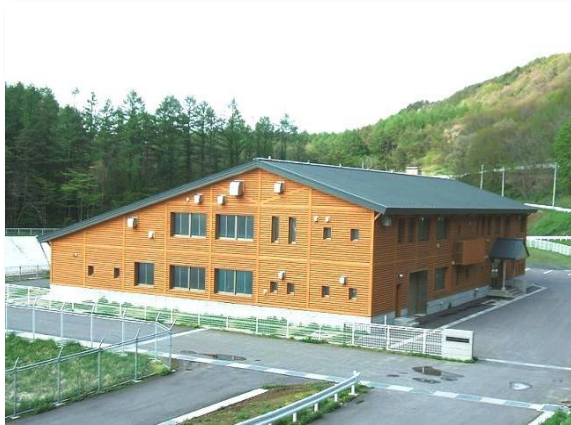
水をきれいにする施設(外からみた様子) ※施設は令和4年度に取り壊しました
