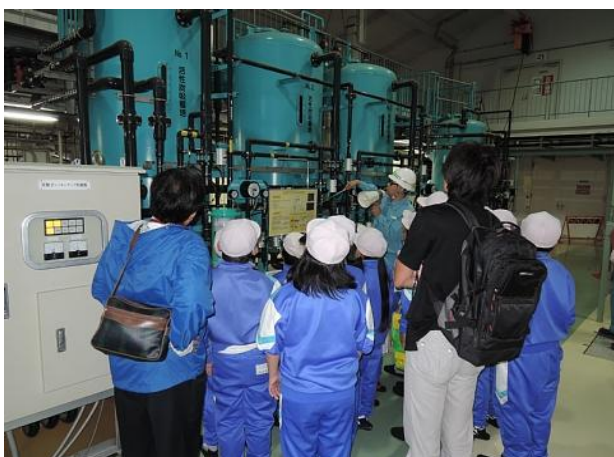
斗川小学校4～5年生(浸出水処理施設)
