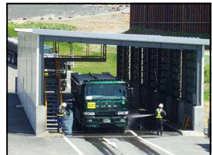
せんしゃせつび 洗車設備
