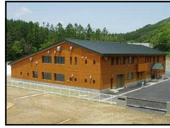
しみしゅつすいしよりしせつ たてもの 浸出水処理施設の建物
