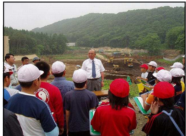
しんしゅつすいしよりしせつ こうじちゅう ほうこう み 浸出水処理施設（工事中）の方向を見て
