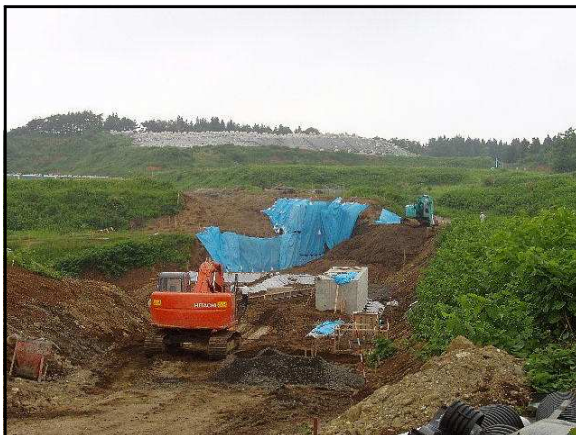
せんしゃせつびふきん こうじちゅう 洗車設備付近（工事中）
