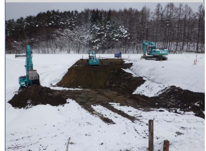
浸出水処理施設撤去工事 施設撤去後周辺掘削状況（R5.1.24時点）
