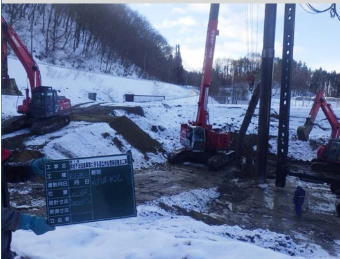
浸出水処理施設撤去工事 基礎杭引抜き状況（R4.12.26時点）
