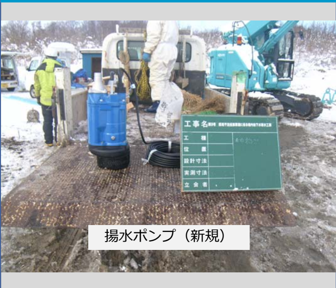
揚水ポンプ・配管修繕 交換する新規ポンプ（CW-3）
