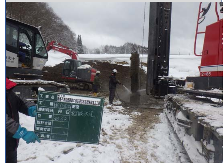
浸出水処理施設撤去工事 基礎杭引抜き状況（R4.12.17時点）
