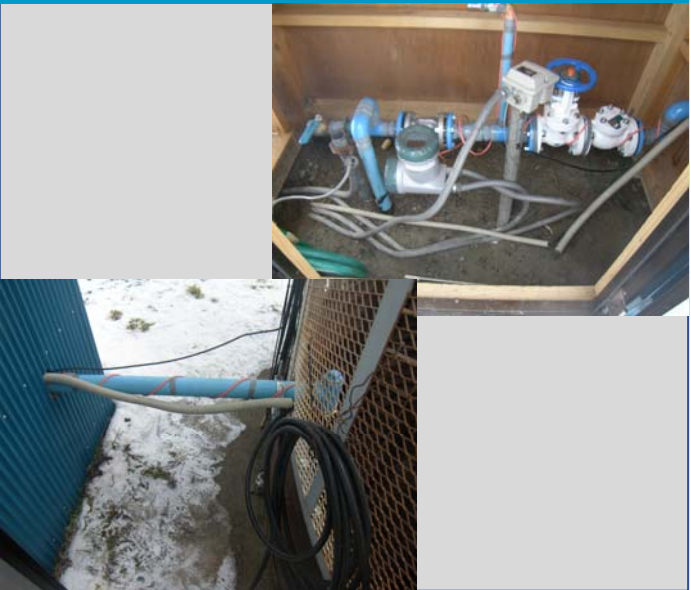
揚水ポンプ・配管修繕 交換後の配管状況（CW-3）
