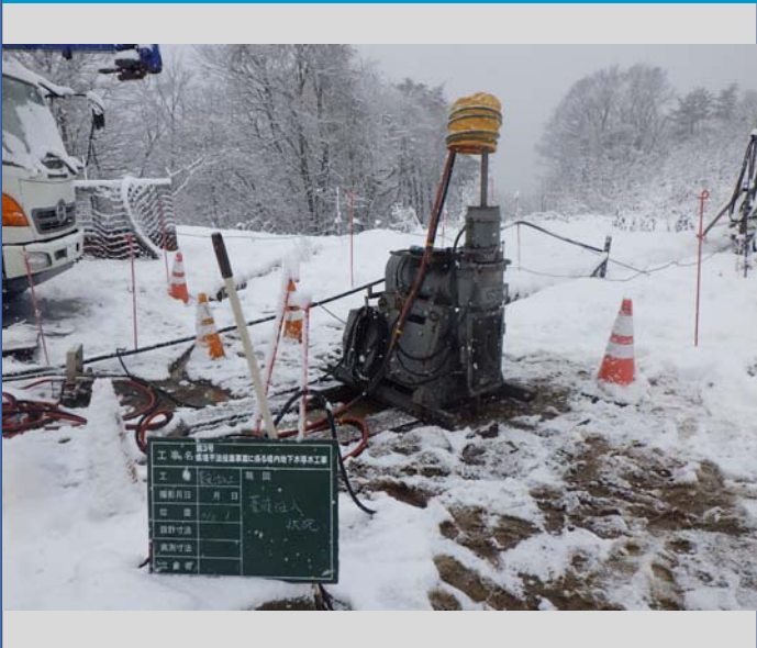
CW-5～CW-6（遮水壁貫通部） 薬液注入工施工状況
