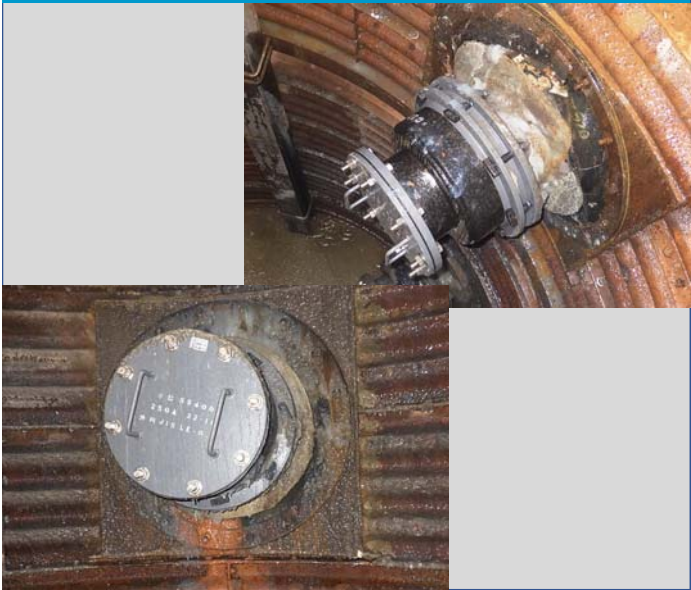
CW-5～CW-6（遮水壁貫通部） 止水蓋設置状況（CW-5側）
