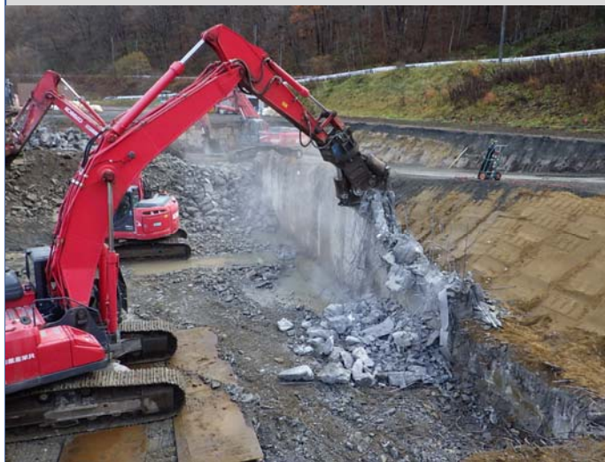
浸出水処理施設撤去工事 基礎解体状況（R4.11.26時点）
