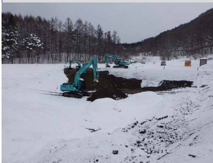
浸出水処理施設撤去工事 施設撤去後周辺掘削状況（R5.1.24時点）
