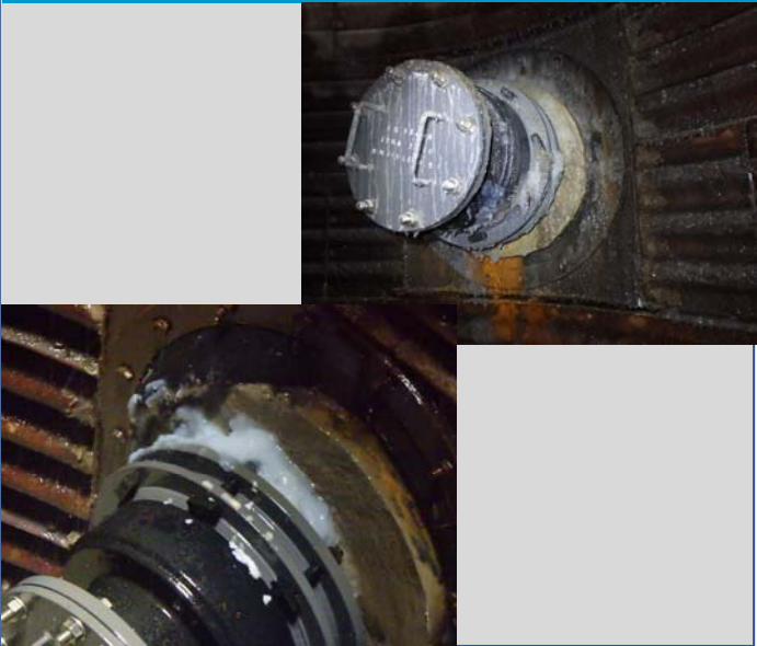
CW-5～CW-6（遮水壁貫通部） 薬液注入工 薬液到達確認（CW-5側）
