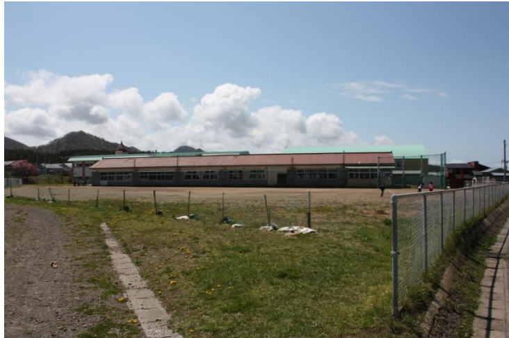
木造旧校舎と現在のグラウンドの様子
