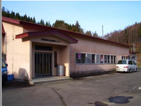
川目地区生活改善センター
