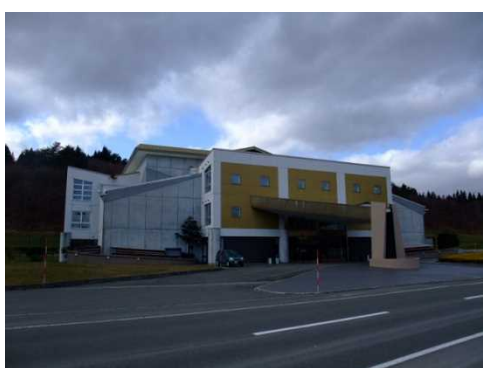
東通村体育館
