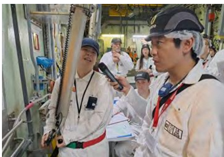
せん断工程施設（操作者は日本原燃の研修生）
