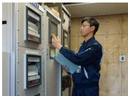
測定器が正常に働いているか点検中
