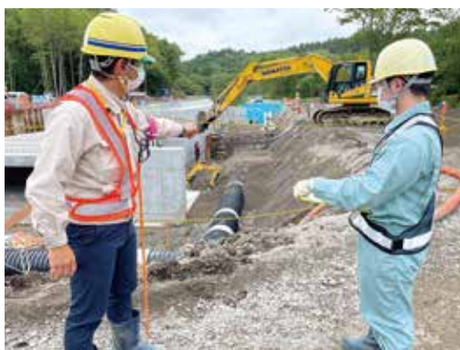
現場で協力会社と進捗状況について打ち合わせ
