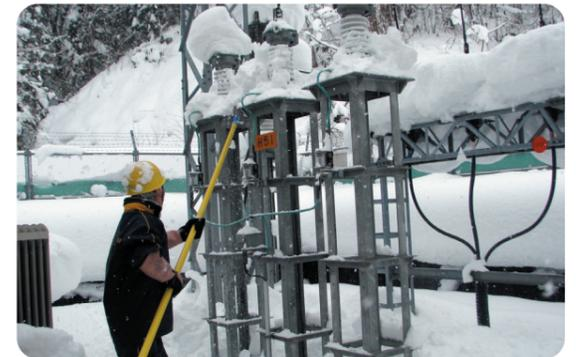
変電設備の上に積もっている雪を片付けている様子
