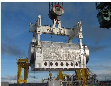
むつ小川原港での荷揚げ作業
