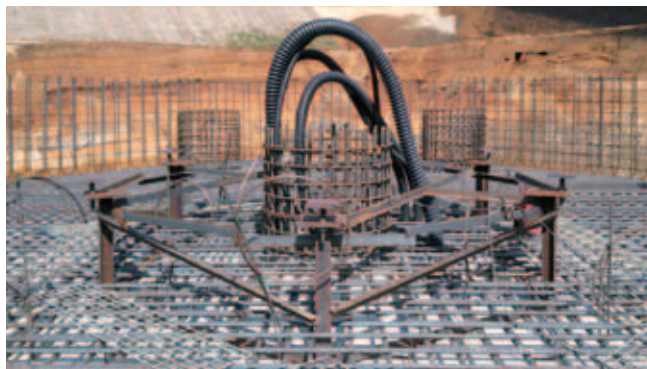
支持架台設置
