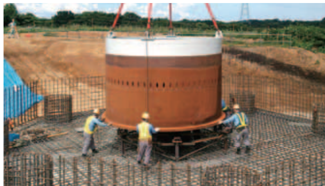
架台上にアンカーリング据付
