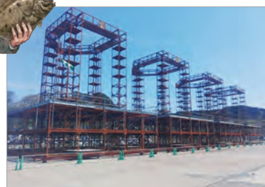
魚礁組立完了全景
