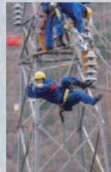
むつ市や八戸市での勤務を経て、現在は主に送電線の巡視点検や修繕業務を担当。自らも鉄塔に登り、落雷による損傷はないか、ショートの原因となる鳥の巣はないか、鉄塔部材に曲がりはないかなどを確認。また、地中送電線ではルート上の地盤チェックや、近傍の掘削工事などで設備に影響がないかなどにも注意を払いながら巡視を行っています。
