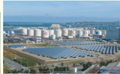
八戸太陽光発電所
