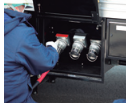
電源車へのケーブル接続
