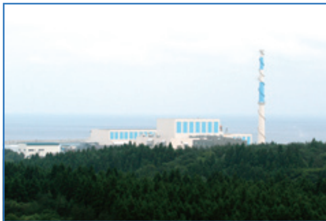
東北電力(株)東通原子力発電所1号機(運転中) 提供:東北電力(株)
