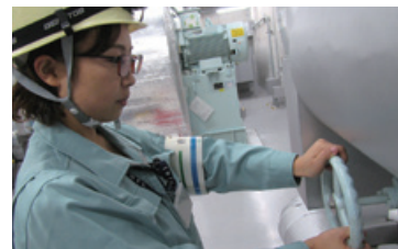
現場作業(バルブ操作)
