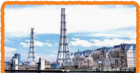
碧南火力発電所
