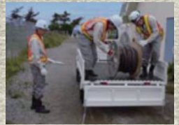
ケーブル敷設訓練
