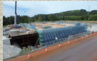
淡水貯水槽建設現場
