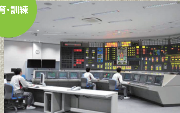
中央制御室の制御盤を模擬した運転訓練シミュレータでの訓練
