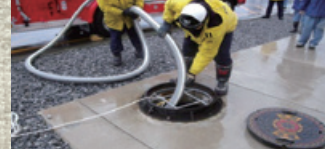
消防車を用いた代替注水
