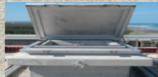
原子炉建屋ベント装置の開放
