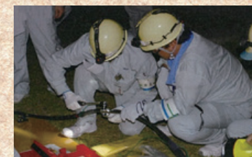
ケーブル接続訓練
