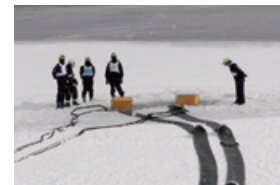
冷却のための 沼からの取水の様子
