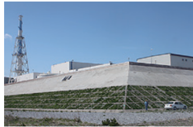
津波浸水対策の防潮堤
