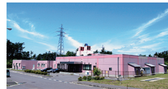
低線量生物影響実験棟
