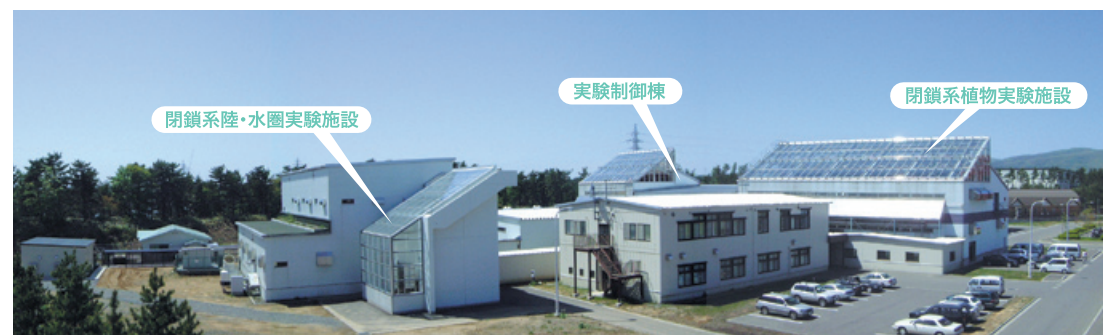
閉鎖型生態系実験施設
