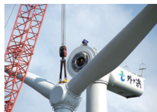
ブレード取付作業
