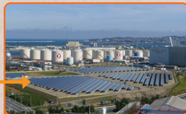
八戸太陽光発電所 (八戸市)
