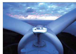
ナセル上部の航空障害灯
