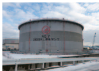
石油貯蔵タンク
