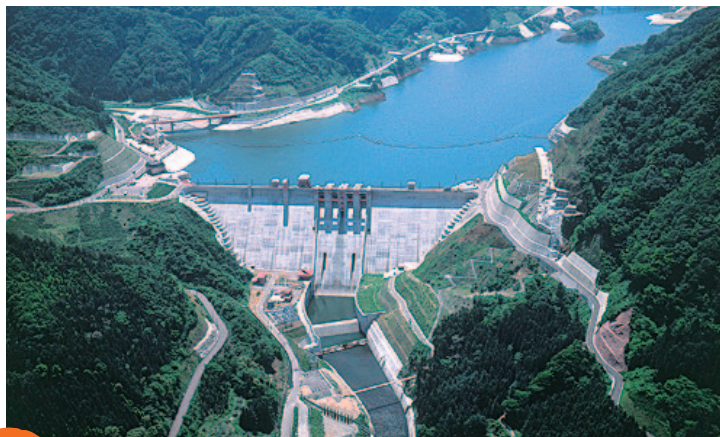
浅瀬石川ダムと発電所全景
