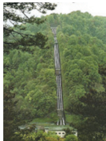
■東北電力十和田発電所 (ダムを作らないで大きな管で水を運んできて発電する水力発電所)
