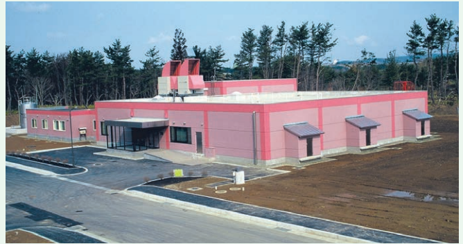
低線量生物影響実験棟
