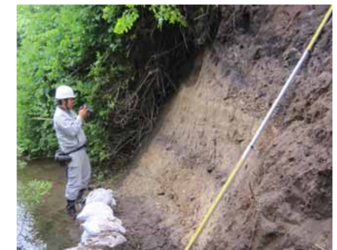
図5 露頭調査作業状況(事例)
