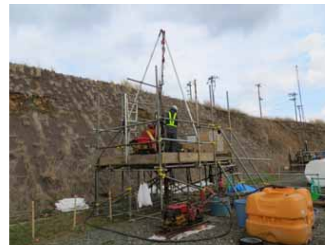
図4 ボーリング調査作業状況(事例)
