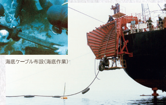
1979年 海底ケーブル布設工事のようす
