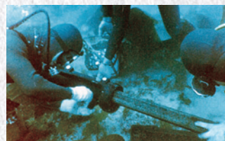
海底ケーブル布設(海底作業)
