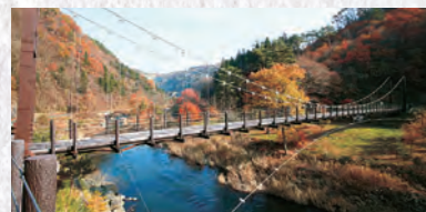
旧島守発電所保存公園へ続く連絡橋(鷹ノ巣吊橋)
