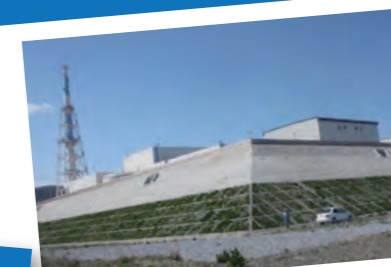
防潮堤・防潮壁の設置
