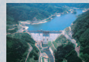
●浅瀬石川発電所は、青森県内唯一のダム式発電所であり、浅瀬石川ダム直下に設置されています。
