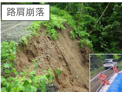
路肩崩落(応急対策完了)
