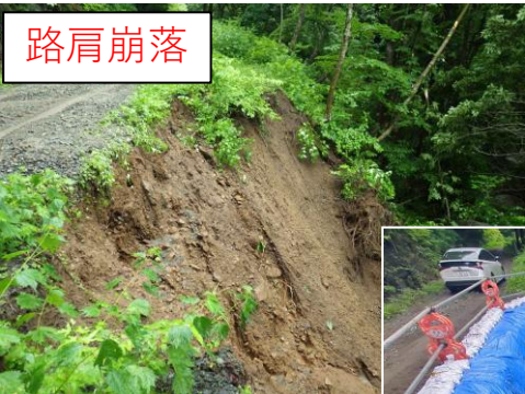
路肩崩落(応急対策完了)
