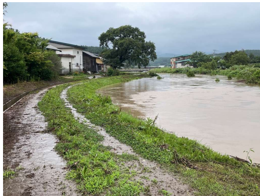
山王川溢水状況
