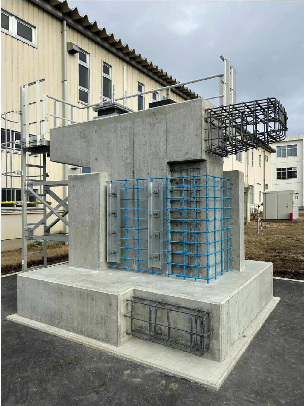
RC 橋脚の耐震補強工法
