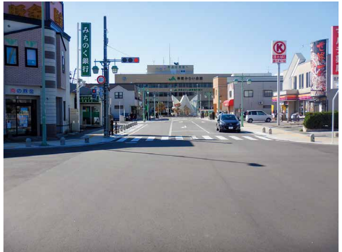
交通安全施設整備（電線共同溝）事業 （町居平賀停車場線・本町工区：平成29年7月完成）
