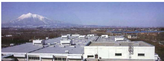
岩木川浄化センター
