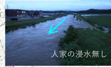
宮野沢川越水状況
