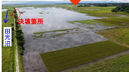
②浸水状況 8/14
