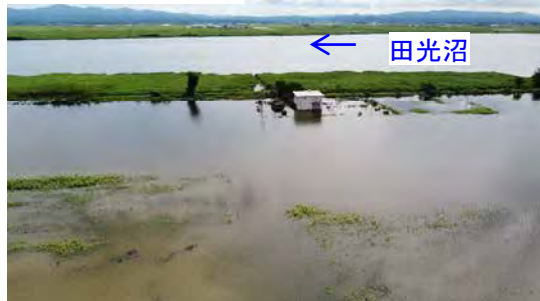
③浸水状況 8/14
