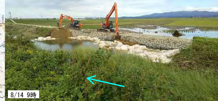
中里川応急作業状況
