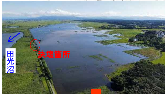
②浸水状況 8/13
