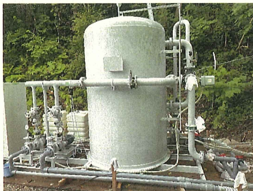
仮設浄水処理ユニットの搬入、設置（8/20）
