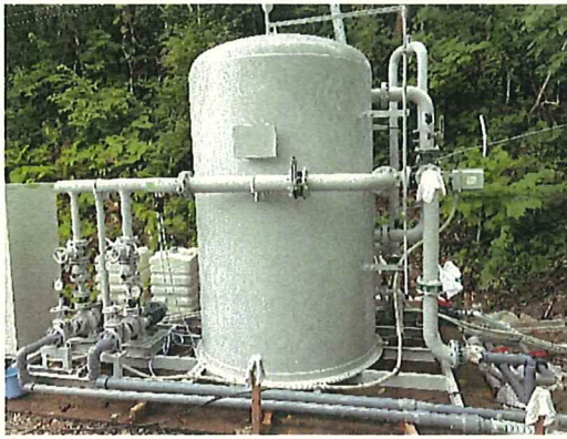
仮設浄水処理ユニットの搬入、設置 (8/20)
