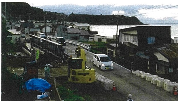
小赤川橋の仮橋
