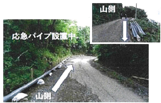
応急パイプ設置
