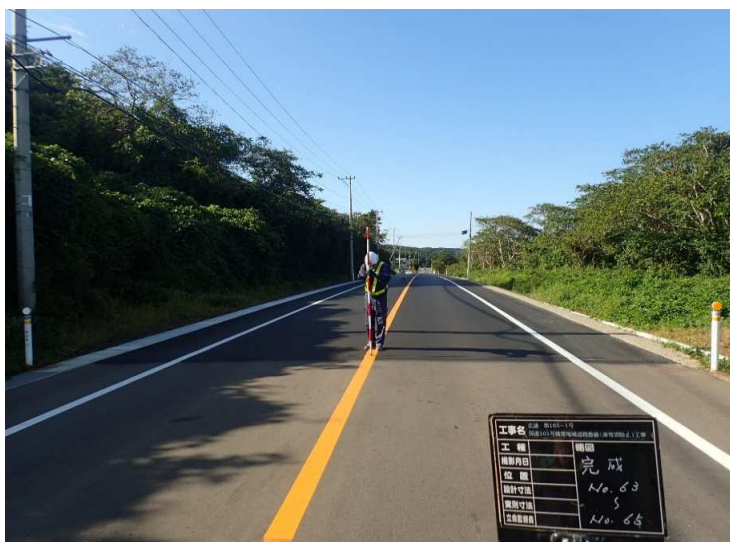
■国道101号積寒地域道路整備（凍雪害防止）工事_深浦町 完成検査：令和5年11月7日
