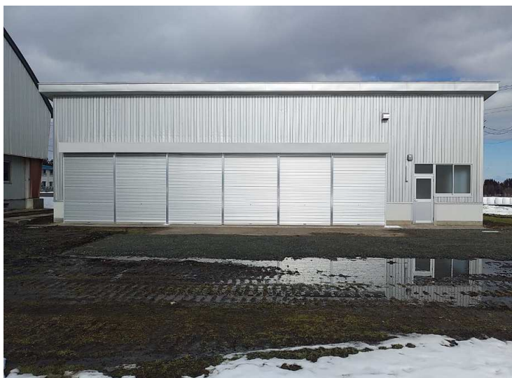
■ 宮農大学校(農業機械整備実習舎外)改修工事_七戸町 完成検査：令和6年2月9日
