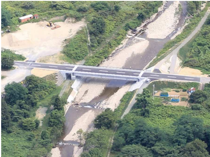
■三厩停車場竜飛崎線橋梁架替（新增川川橋）工事_外ヶ浜町 完成検査：令和5年9月8日
