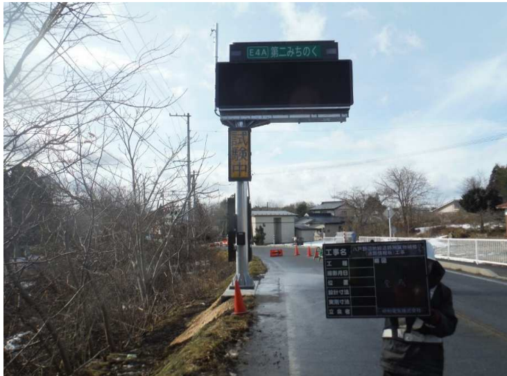
■八戸野辺地線道路附属物補修（道路情報板）工事_六戸町 完成検査：令和6年2月28日
