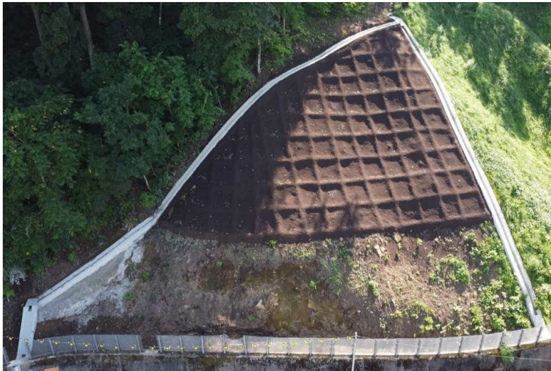
■山田2号区域急傾斜地崩壊対策工事_弘前市 完成検査：令和5年9月25日
