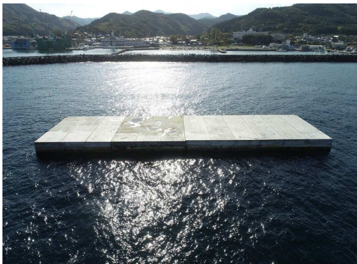
■ 佐井地区水産生産基盤整備工事_佐井村 完成検査：令和5年11月6日
