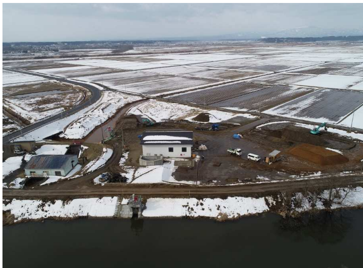
■土場川県ぼ第261号工事_東北町 出来形検査：令和6年3月22日
