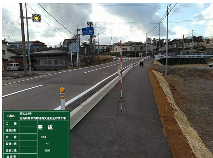
■五所川原車力線道路交通安全対策工事_つがる市 完成検査：令和6年3月21日
