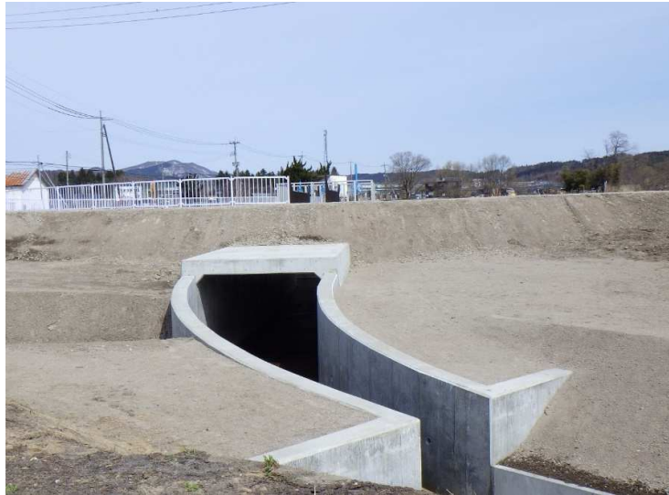
■大堤ため池第5号工事_青森市 完成検査：令和6年3月29日
