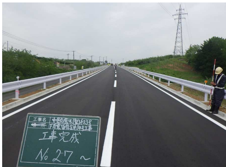
■下・原農道保全第34号工事_弘前市 完成検査：令和5年6月28日
