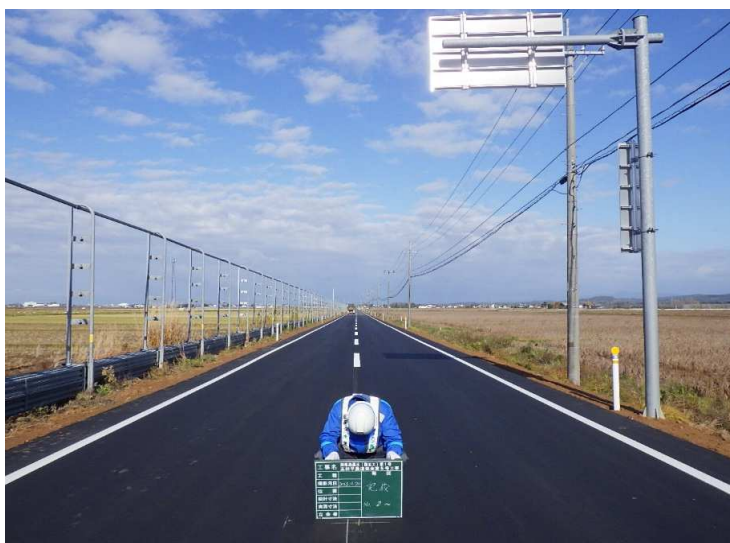
■ 五林平農道保全第5号工事_板柳町 完成検査：令和5年11月30日
