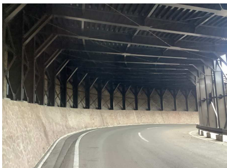
■国道454号シェッド・シェルター補修（宇樽部スノーシェッド）工事_十和田市 完成検査：令和5年11月21日
