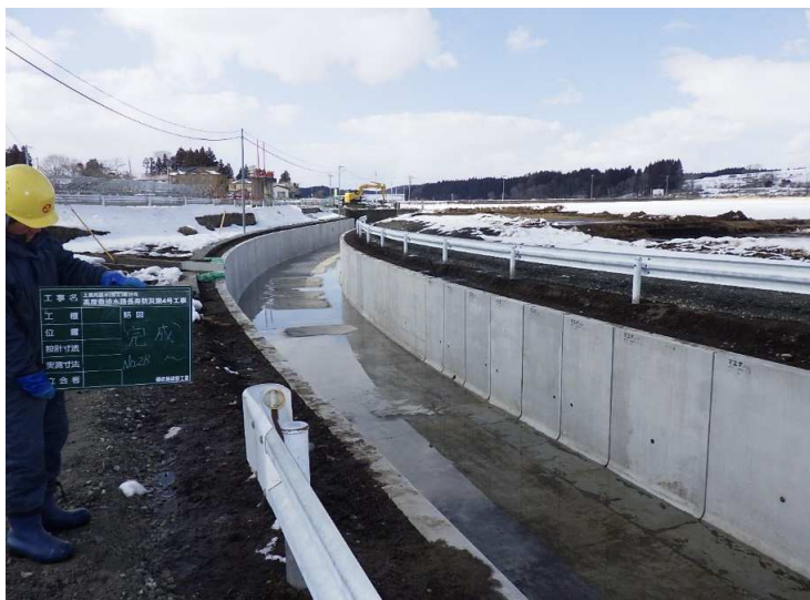
■高屋敷排水路長寿防災第4号工事_六戸町 完成検査：令和6年3月14日
