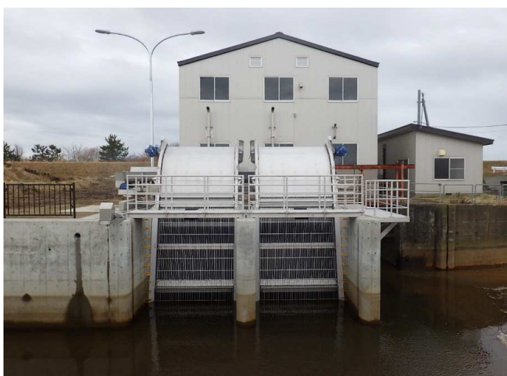
■小田川南部合理化第30号工事_五所川原市 完成検査：令和6年3月7日
