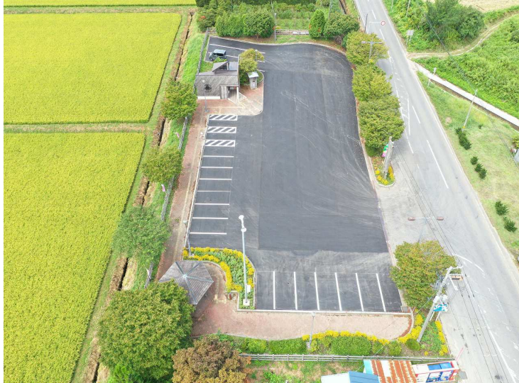
■国道104号（やすらぎの駐車帯）舗装補修工事_田子町 完成検査：令和5年9月28日
