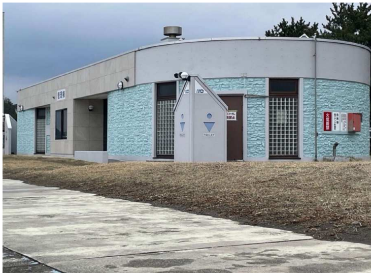
■ サンセットビーチあさむし管理棟改修工事_青森市 完成検査：令和5年12月22日
