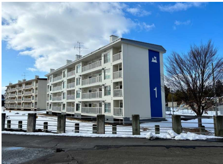
■県営住宅（茂森団地）1号棟屋根・外壁改修工事_弘前市 完成検査：令和5年12月8日
