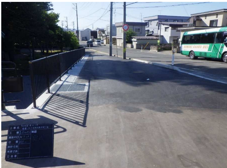
■国道280号道路改築（交安）工事_青森市 完成検査：令和5年8月10日
