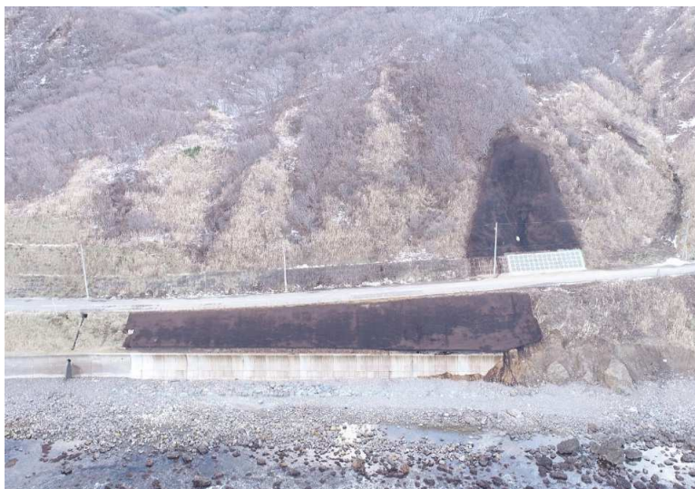
■国道339号道路災害復旧工事_中泊町 完成検査：令和6年2月13日
