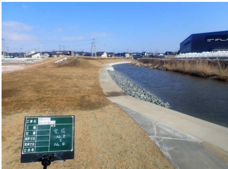
■浅水川河川維持工事_八戸市 完成検査：令和6年3月26日
