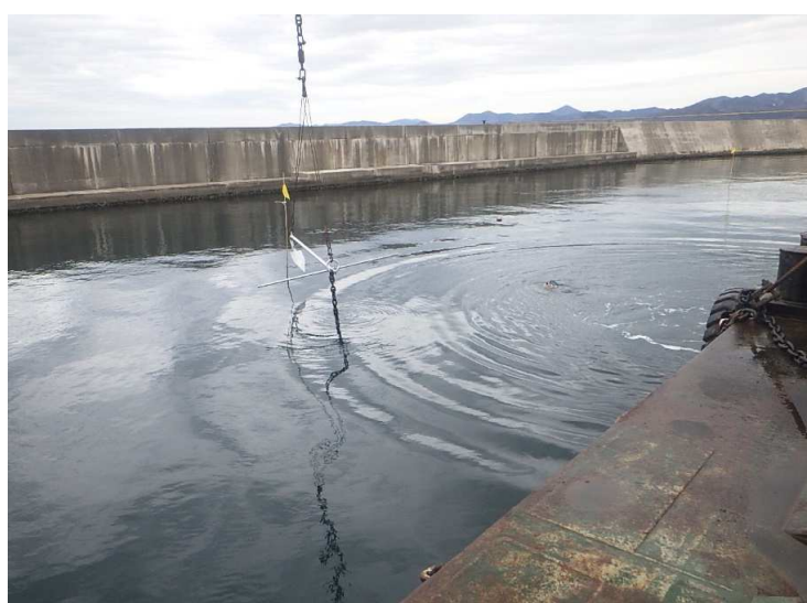
■漁業取締船係留施設改修工事_青森市 完成検査：令和6年3月13日
