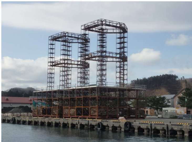
■ 青森県津軽海峡地区（東部魚礁第1工区）水産環境整備工事_佐井村 中間検査：令和6年1月24日
