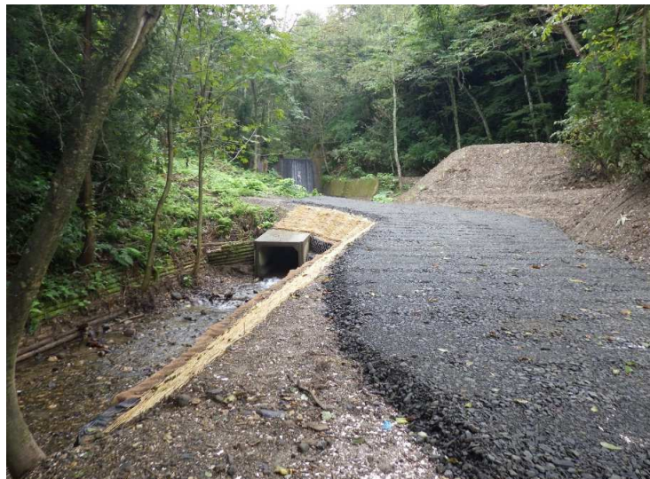
■令和4年度県営自然災害防止工事_外ヶ浜町 完成検査：令和5年10月6日
