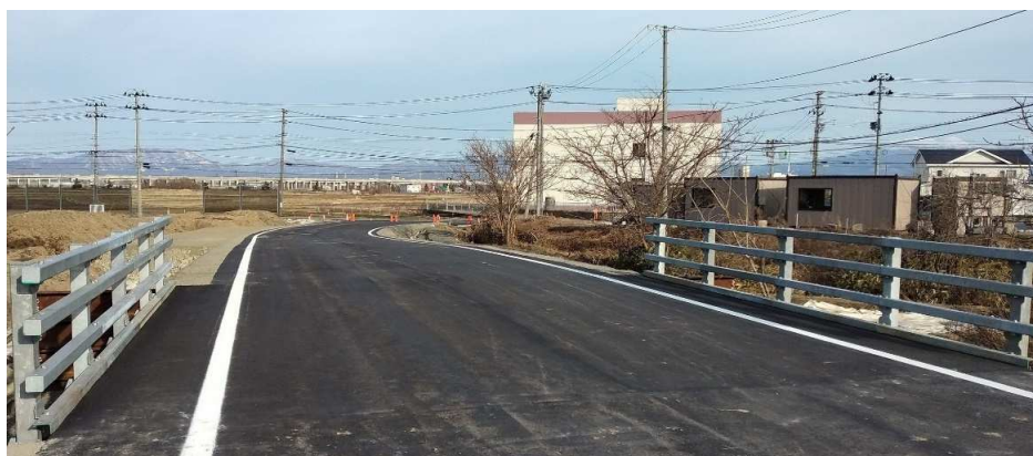
■消防学校橋梁架替工事_青森市 完成検査：令和6年3月28日
