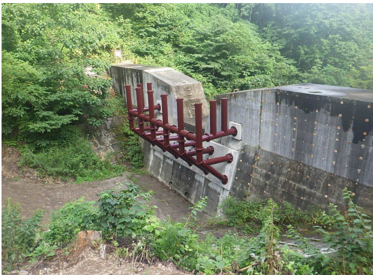
■西森合沢総合流域防災砂防（流木対策）工事_黒石市 完成検査：令和5年9月8日
