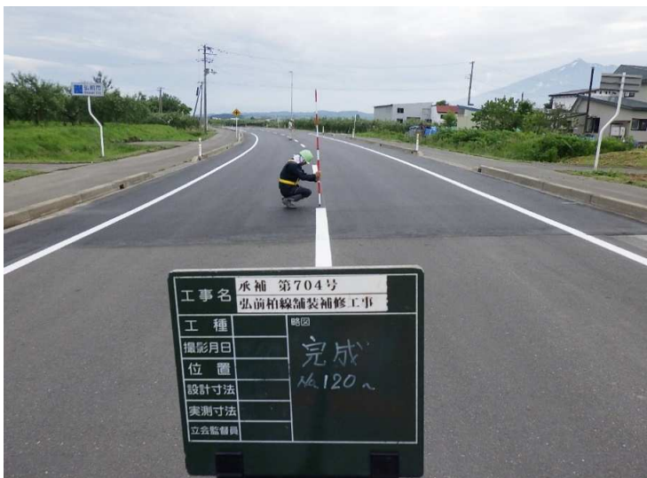
■弘前柏線舗装補修工事_弘前市 完成検査：令和5年7月14日
