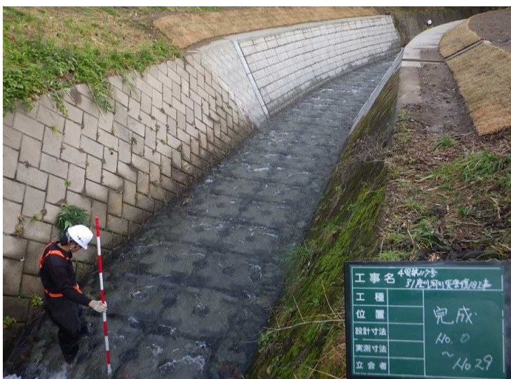
■引座川河川災害復旧工事_平川市 完成検査：令和5年12月27日
