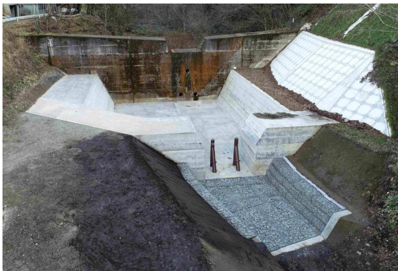
■馬淵川圏域（高瀬沢）総合流域防災砂防工事_南部町 完成検査：令和5年12月26日
