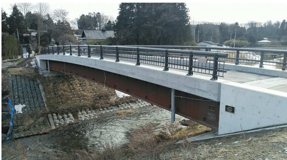
■浅水川広域河川改修工事_五戸町 完成検査：令和6年3月5日
