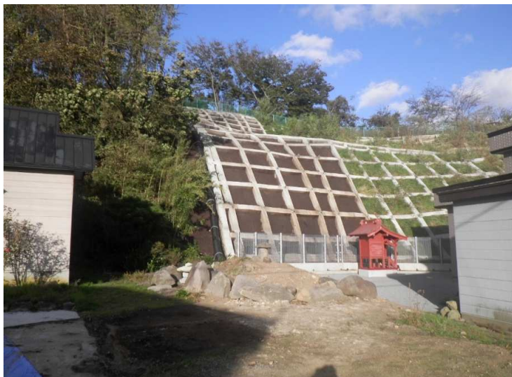
■北浮田町区域急傾斜地崩壊対策工事_鱒ヶ沢町 完成検査：令和5年11月1日
