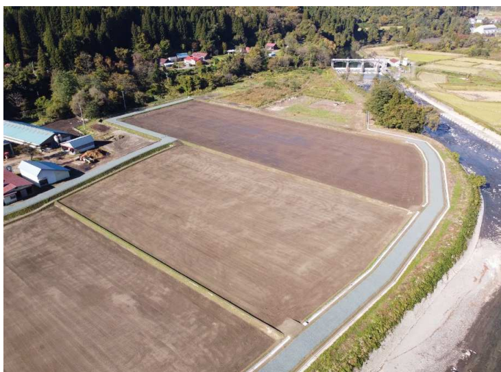
■赤石県ぼ第23号工事_十和田市 完成検査：令和5年11月15日
