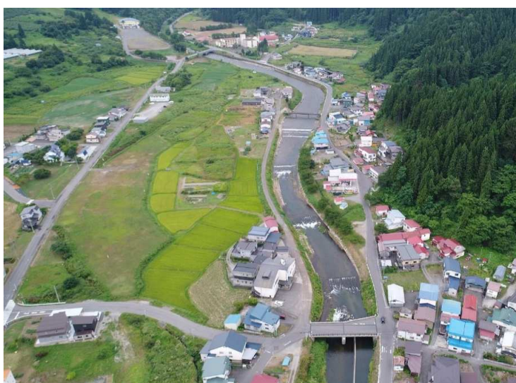
■平川外総合流域防災(虹貝川加速化対策)工事_大鰐町 完成検査：令和5年9月20日
