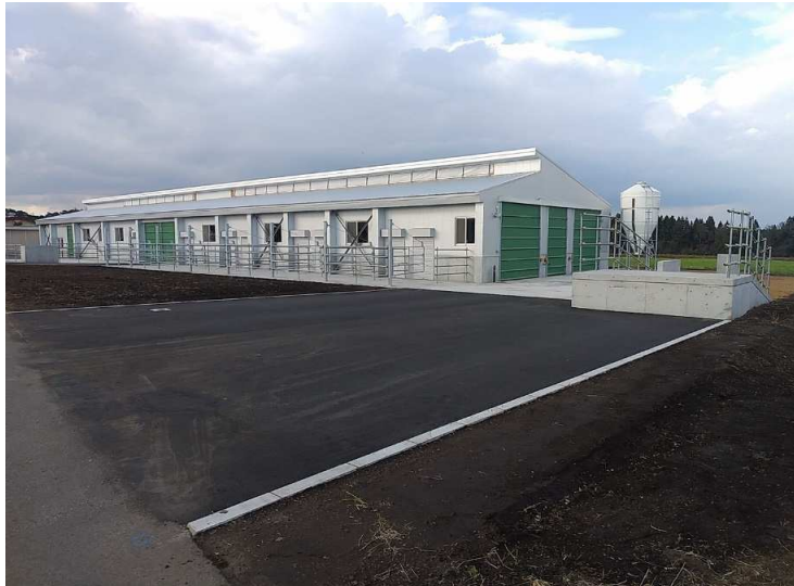
■ 宮農大学校(牛舎)新築工事_七戸町 完成検査：令和5年11月9日
