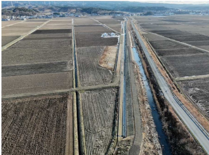
■中里川河川災害復旧工事_中泊町 完成検査：令和6年1月16日
