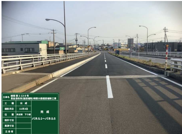
■青森港改修（施設補助）埠頭大橋橋梁補修工事_青森市 完成検査：令和5年12月26日
