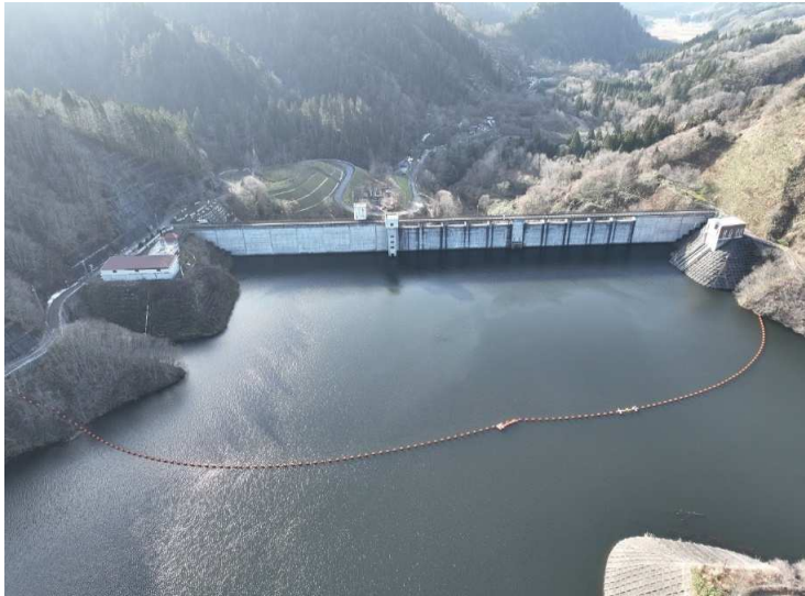
■久吉ダムメンテナンス（網場改良）工事_平川市 完成検査：令和6年2月21日
