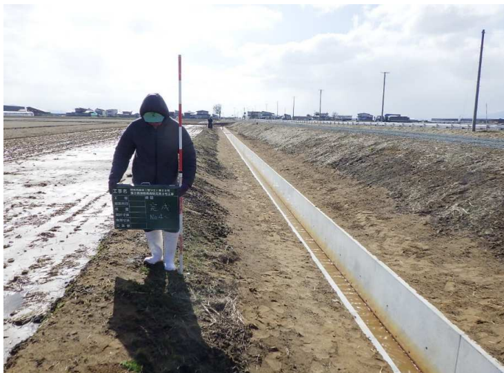
■第2西津軽長寿防災第3号工事_つがる市 完成検査：令和6年3年22日
