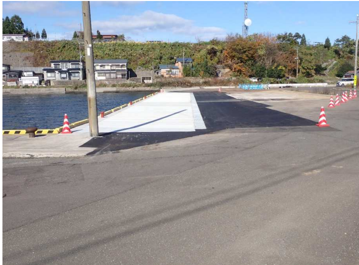
■ 下北地区（大畑漁港）水産物供給基盤機能保全工事_むつ市 完成検査：令和5年12月5日
