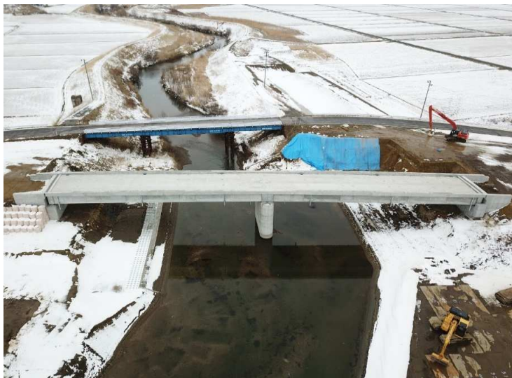
■金木川大規模特定河川工事_五所川原市 完成検査：令和6年3月14日
