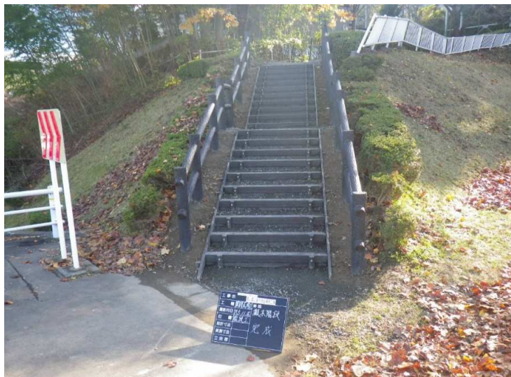
■青い森公園外施設補修工事_青森市 完成検査：令和5年11月27日
