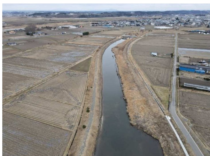
■明神川大規模特定河川改修工事_おいらせ町 完成検査：令和6年3月26日
