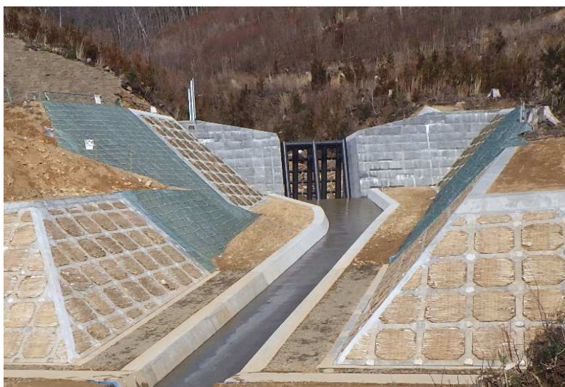
■北畑沢火山砂防工事_むつ市 完成検査：令和6年3月27日
