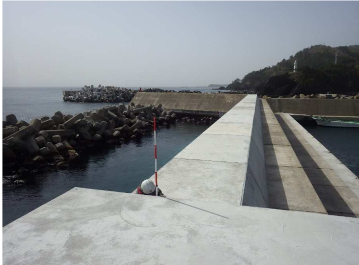
■ 白糠地区漁港施設機能強化工事_東通村 完成検査：令和5年5月18日
