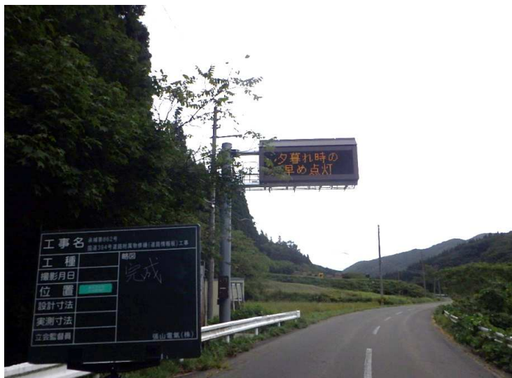
■国道394号道路附属物修繕(道路情報板)工事_黒石市 完成検査：令和5年10月11日
