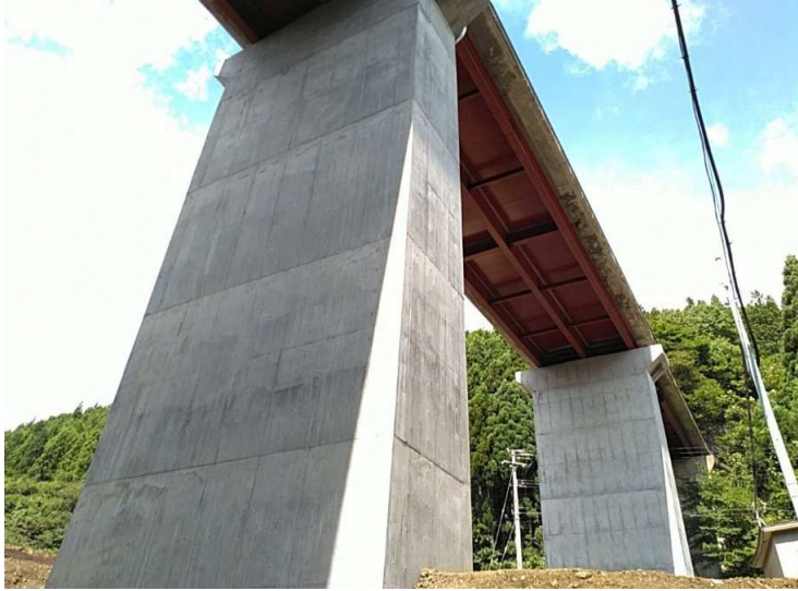
■三厩停車場竜飛崎線橋梁補修（算用師川橋）工事_外ヶ浜町 完成検査：令和5年8月4日
