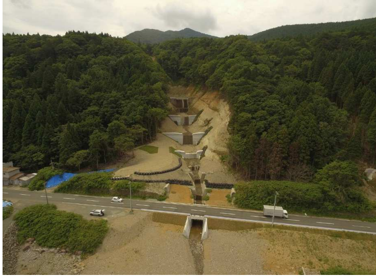
■令和3年度県営災害復旧治山工事_風間浦村 完成検査：令和5年6月9日
