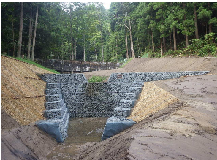
■令和4年度県営予防治山工事_平川市 完成検査：令和5年9月29日
