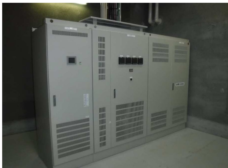
■青森県立中央病院電気設備改修工事（令和4・5年度）_青森市 完成検査：令和5年12月21日
