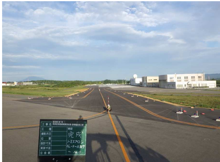
■青森空港整備事業滑走路・誘導路改良工事_青森市 完成検査：令和5年9月5日
