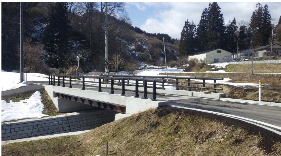
■ 三戸中山間第38号工事_三戸町 完成検査：令和6年3月19日
