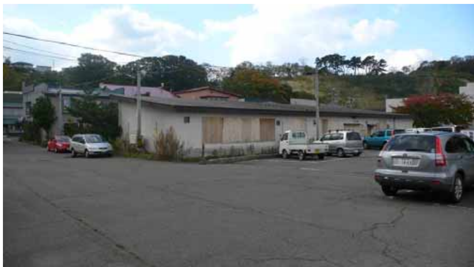
建物全景（北面）
